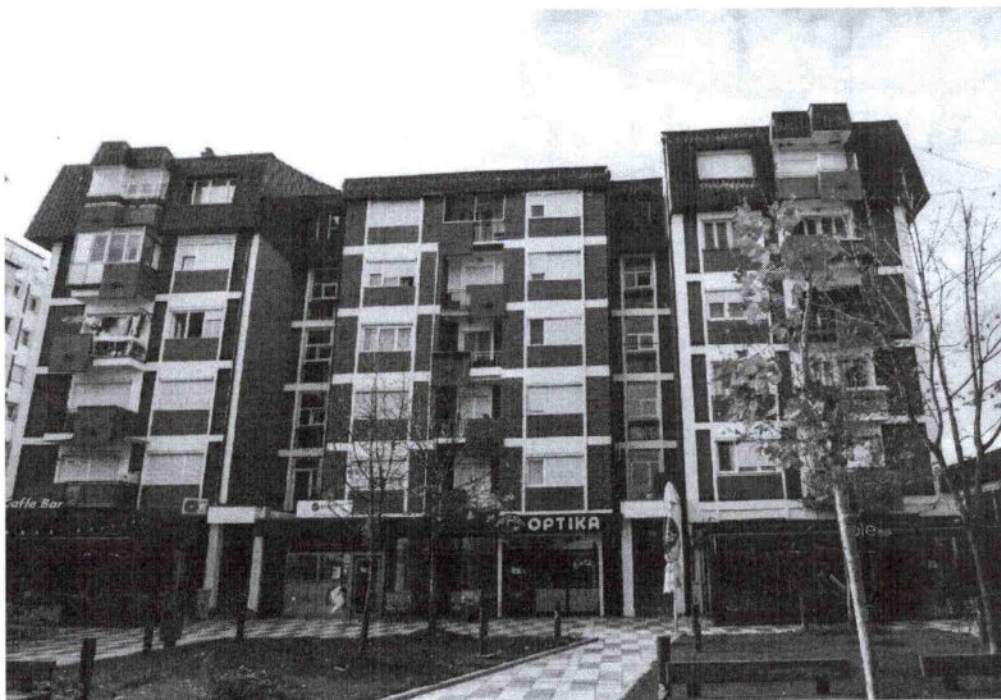
Foto 2. Renoviranje višeporodičnih stambenih objekata u gradu
