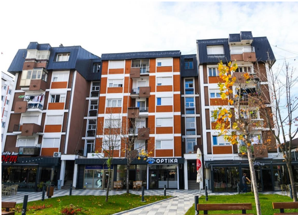
Foto 2. Renovimi i objekteve shumë banesore në qytet
