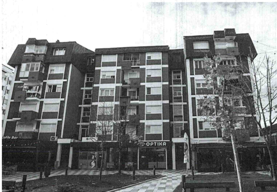
Slika 2. Renoviranje stambenih zgrada u gradu
