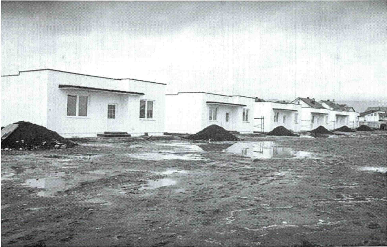
Slika 8. Naselje u izgradnji a finansira udruženje "Albanci za Albance"
