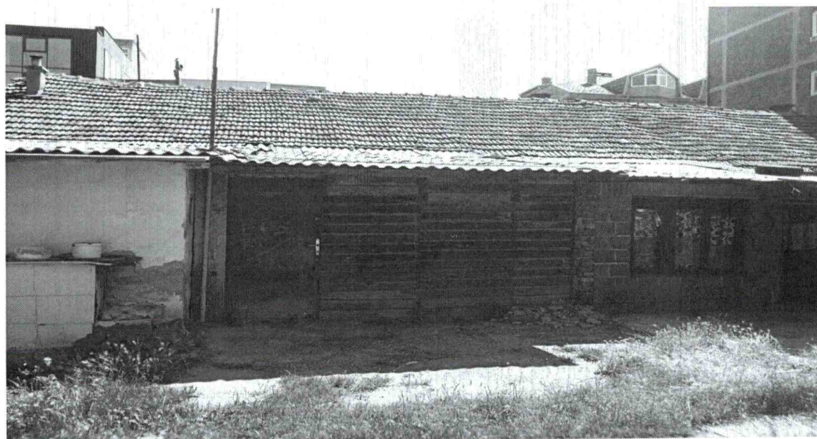
Slika 7. Zgrada u ulici "Nuhi Gashi" (u kojoj žive 4 porodice)
