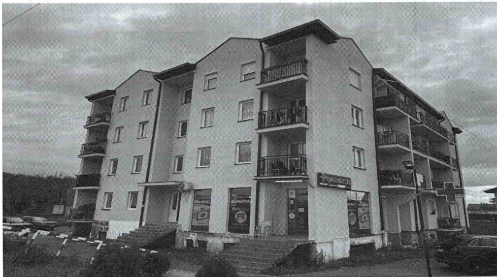
Slika 5. „ Stambena zgrada kod željeznice “ (u kojoj žive 23 porodice)
