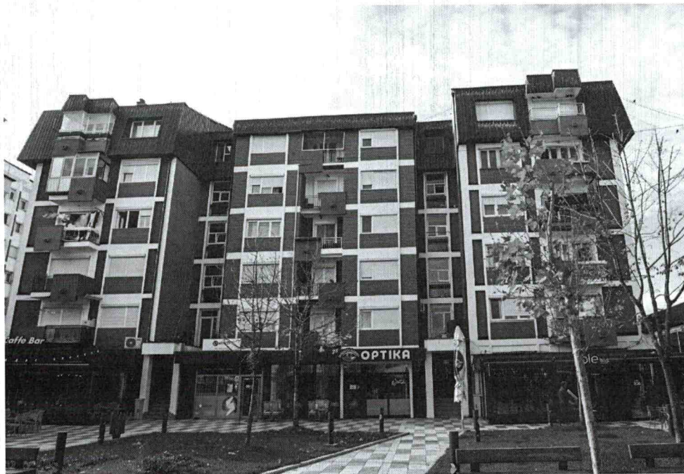
Slika 2. Renoviranje stambenih zgrada u gradu
