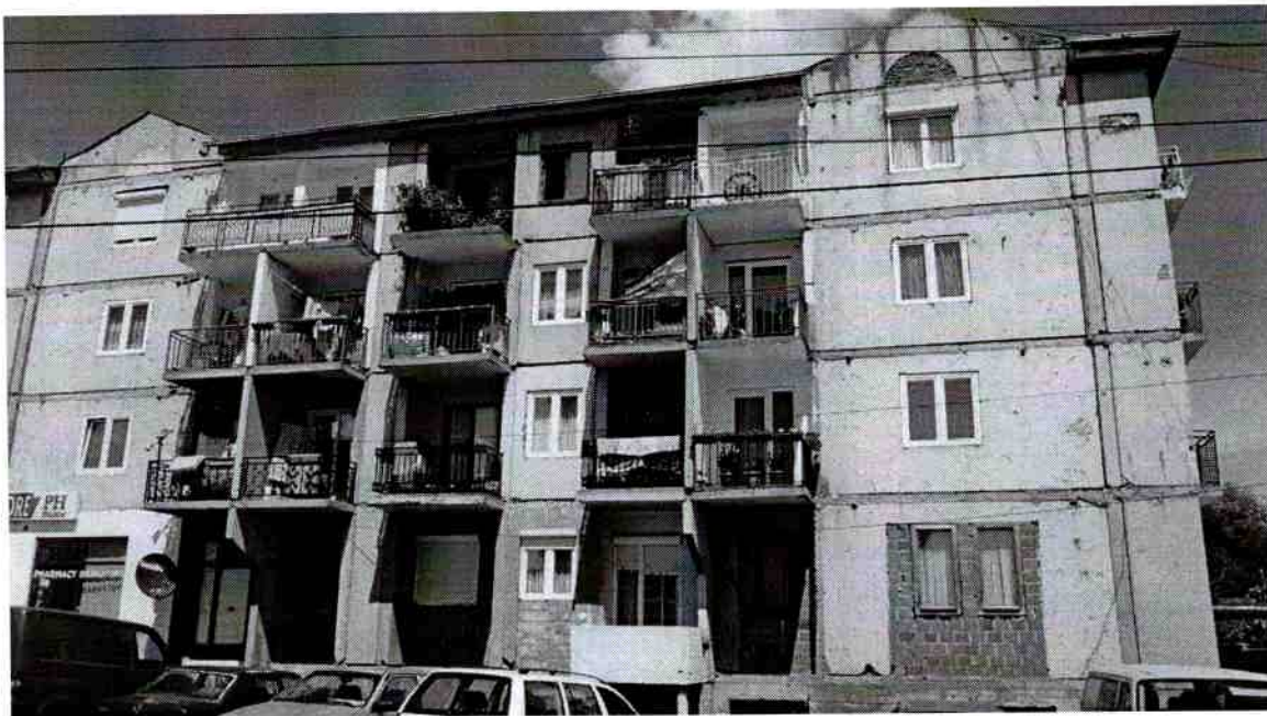
Foto 3 Objekti banesor Rr.„Hekurudha”
